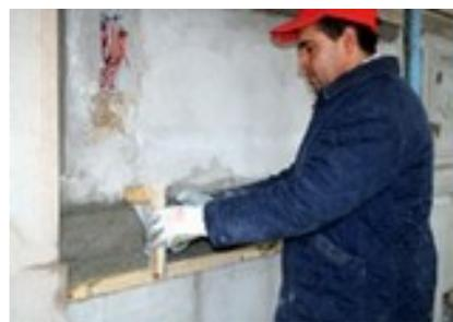
100. Ripristino e ricostruzione del cornicione sottotetto e delle relative mensole decorative Eseguite presso il cantiere di **Via Roma 8 Genova** (inverno 2006)
