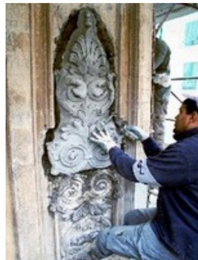
101. Ripristino delle decorazioni architettoniche a rilievo eseguite sulle facciate palazzina di **P.zza della Giovane Italia Genova** (inverno 2007)
