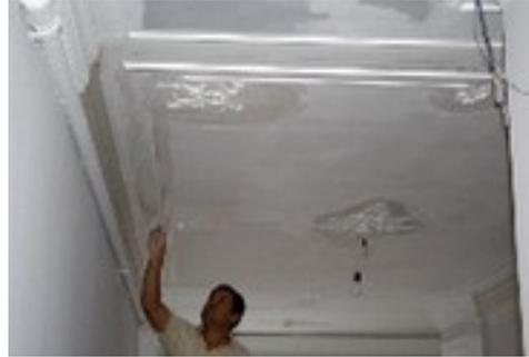
105. Ricostruzione delle volte a crociera eseguite lungo il porticato esterno della **Chiesa di S. Andrea di Lavagna, Genova** (estate 07)
